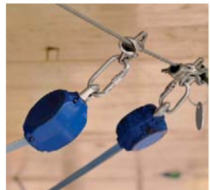
3 Sistema a fune di tipo fisso conforme alla norma EN 795 con ancoranti intermedi superabili.
