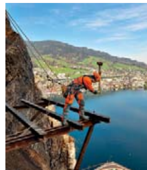
3 Situazioni estreme: per questi lavori sono richiesti una formazione particolare e anni di esperienza.
