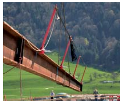
3 Limitare il più possibile i lavori con i DPI anticaduta effettuando il premontaggio a terra.
