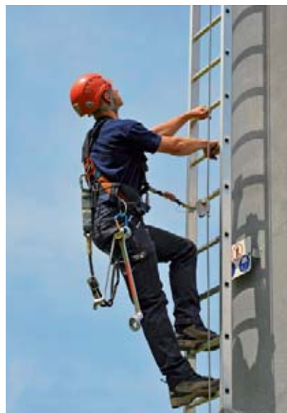
3 Sistema anticaduta su pali per la telecomunicazione mobile
